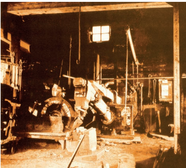
Bild 1.2: Wasserkraftgetriebener Eisenhammer (um 1780)
