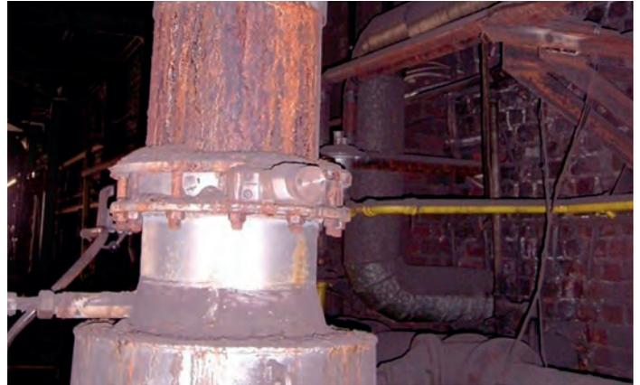
Bild 2: Verrottete Abgasklappe
