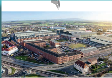
Ende des 19. Jahrhunderts entstand das heutige Schuler-Werk in Erfurt, in dem zunächst noch Stanzen und Scheren gefertigt wurden. Bild: Schuler
