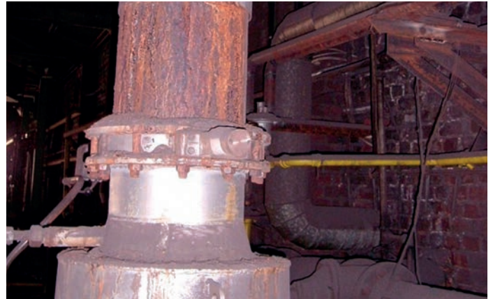
Bild 2: Verrottete Abgasklappe
