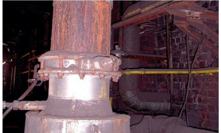
Bild 2: Verrottete Abgasklappe
