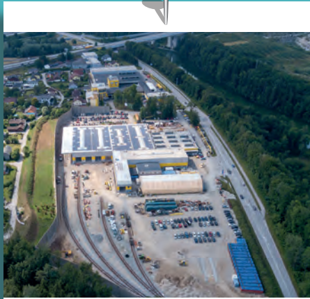
LINSINGER-Firmengelände mit der um 5.000 m 2 erweiterten Produktionsfläche
