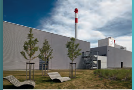
Teilansicht der neuen Produktionshalle
