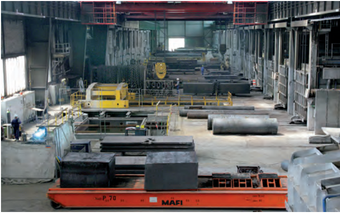
Bild 9: In der Vergütereier flankieren großformatige Herdwagenöfen die Abkühlbecken.
