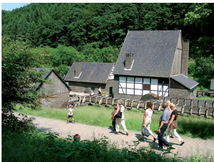
Bild 3: Mit der Entwicklung von Wasserradgetriebenen Hammerwerken begann ein neuer Abschnitt in der Schmiedetechnik. In Hagen ist ein kompletter Aufwurfhammer zu sehen, der dazu diente, Roheisen aufzuarbeiten.
