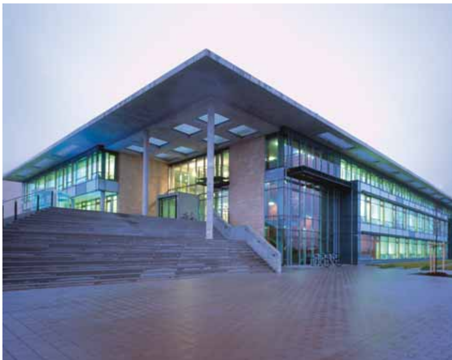
Bild 2: Laborgebäude („Newtonbau“) der Fakultät Maschinenbau, Technische Universität Ilmenau.
