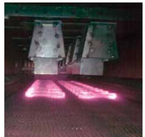
Bild 3: Absaugvorrichtung der Abwärme.
