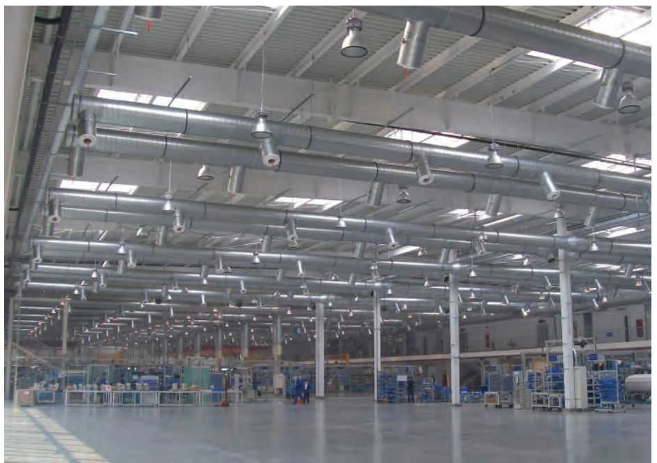
Bild 2: „Der Bau ist ein Meilenstein. Ein Gebäude ist die Hülle, in der verschiedene Prozesse ablaufen und Menschen mit Maschinen Produkte herstellen.“
